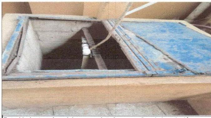
Foto 11: La tapadera del pozo se deterioro por años de instalación.
