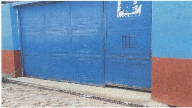
Foto 1: La parte inferior del porton ya se encuentra en mal estado.
